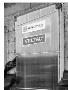
Eksempel på afdækning før færdig udvendig mur.
