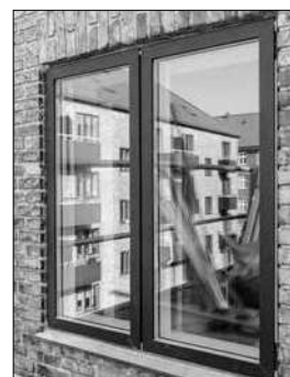
Montering i vand- og snetæt bygning.
