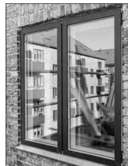
Montering i vand- og snetæt bygning.
