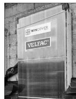
Eksempel på afdækning før færdig udvendig mur.
