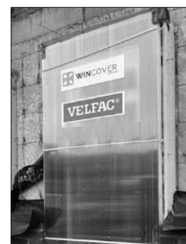
Eksempel på afdækning før færdig udvendig mur.
